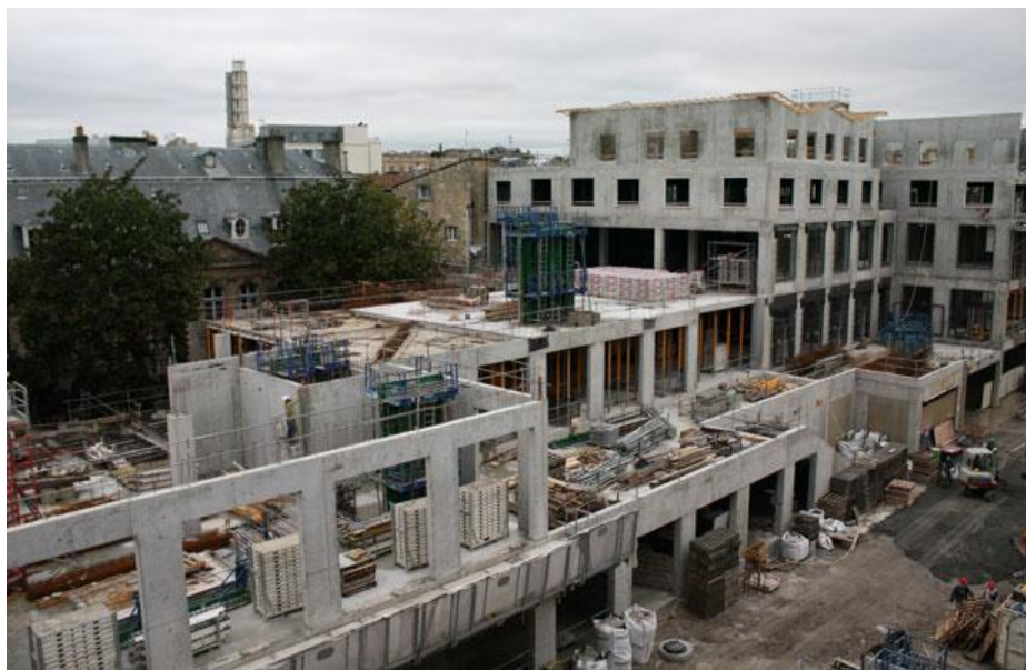
Construction du programme immobilier Carré Cheverus à Bordeaux — M.B./20MINUTES
